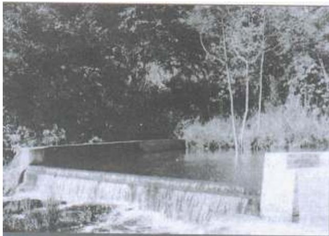
A foto acima mostra um vertedor de uma pequena barragem de elevação de nível. Os vertedores são simples paredes, diques ou aberturas sobre as quais um líquido escoar. Quanto às aplicações dos vertedores na hidráulica, julgue os itens subsequentes.
