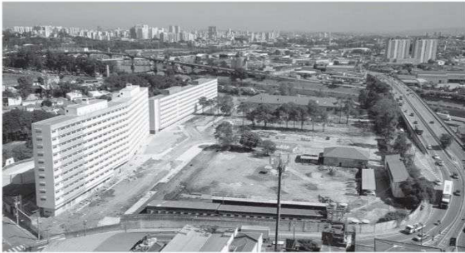
Foto da primeira etapa construída
