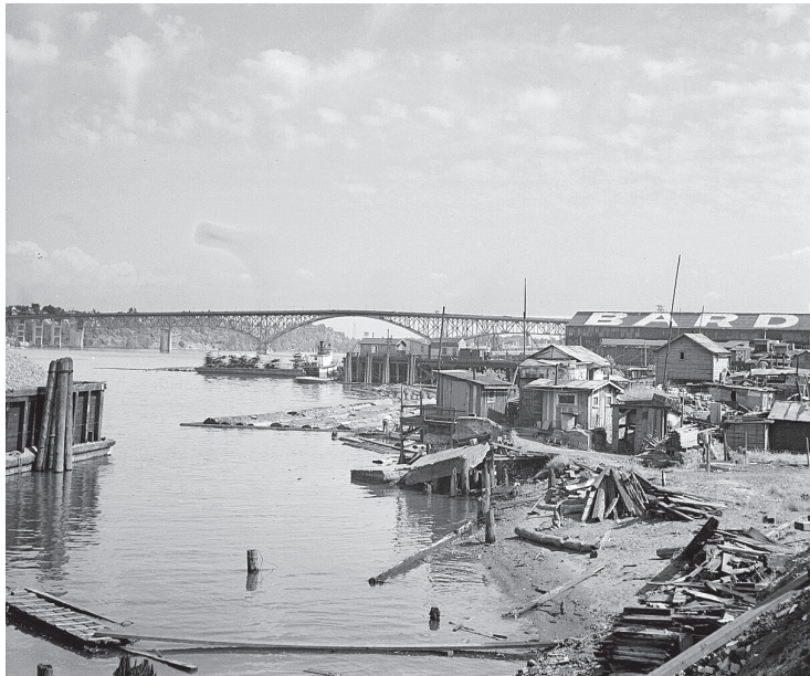
Barracos de ocupantes ilegais ao longo do rio Willamette, em Portland.
