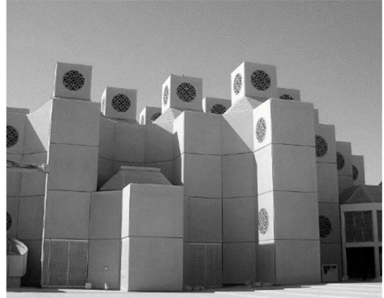
Exemplo de chaminé de vento na Universidade do Qatar, em Doha. Fonte: Sky2105 - Own work, CC BY-SA 3.0, https://commons.wikimedia.org/w/index.php?curid=17433609
