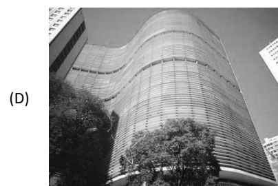
Edifício COPLAN, na cidade de São Paulo.
