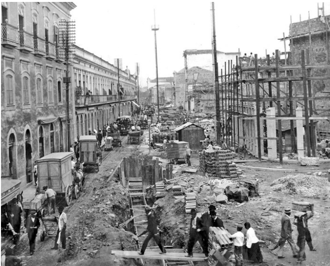
Rua da Carioca em obras – Augusto Malta, 31/01/1906 – AGCR
