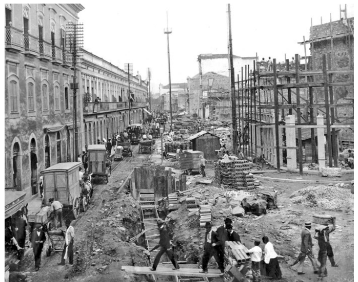
Rua da Carioca em obras – Augusto Malta, 31/01/1906 – AGCR
